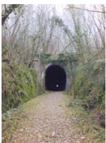
18 Entrée tunnel Côté Colombier
