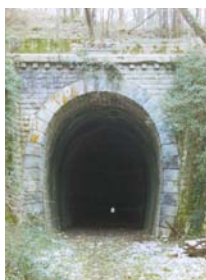
19 Entrée tunnel Saint Raphaël
