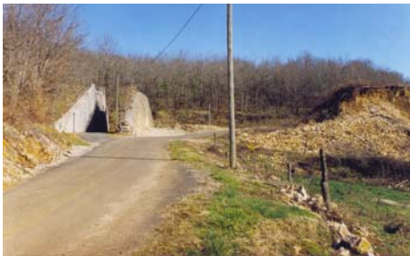
10 Viaduc du Colombier
