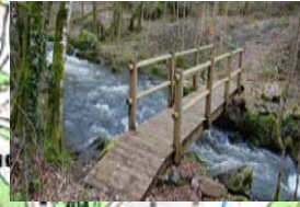
Passerelle sur le Porte Etoupe
